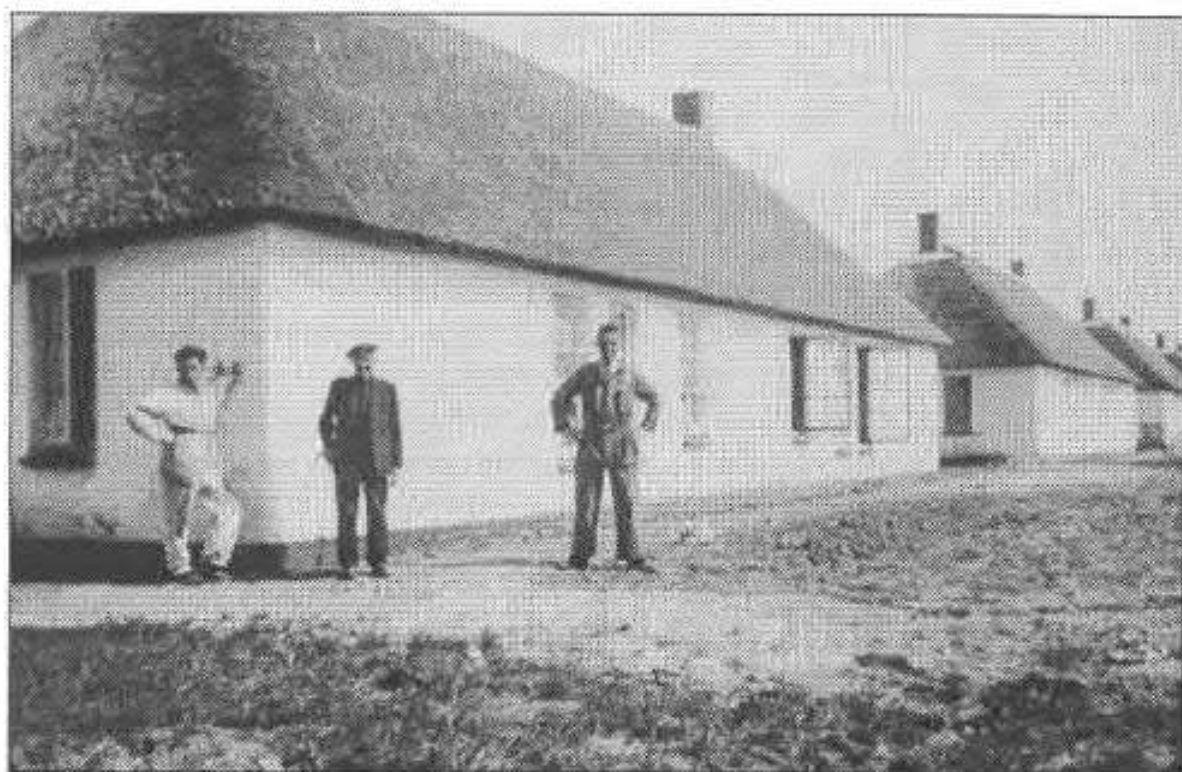
Noodwoningen in aanbouw aan de Veldstraat, 1945. V.l.n.r.: Lee Bimbergen, Jan de Mol en Jan Jordens. Fraai voorbeeld van schilddak.
