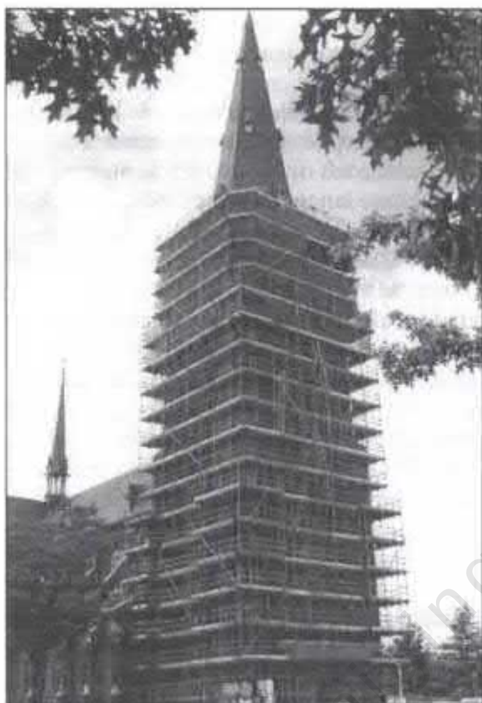
In het voorjaar van 1999 werd begonnen met de restauratie van de monumentale St. Willibrorduskerk. Na Pasen ging de toren in de steigers.
