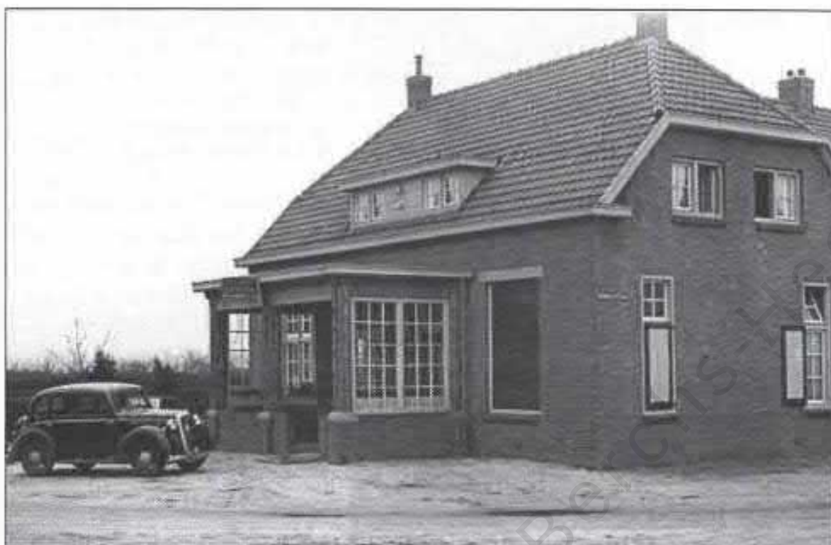
1949. Nieuwbouw Café Marcellus van Vugt in het Duurendseind, op de hoek van de Burg. van Erpstraat-Runselstraat. In 2002 ging het pand tegen de vlakte om weer plaats te maken voor nieuwbouw. Foto: Daan Scholte.
