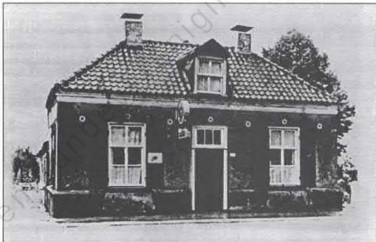
De oorspronkelijke 'Heesche Barrière' werd in 1970 gesloopt in verband met de omlegging van de rijksweg.
